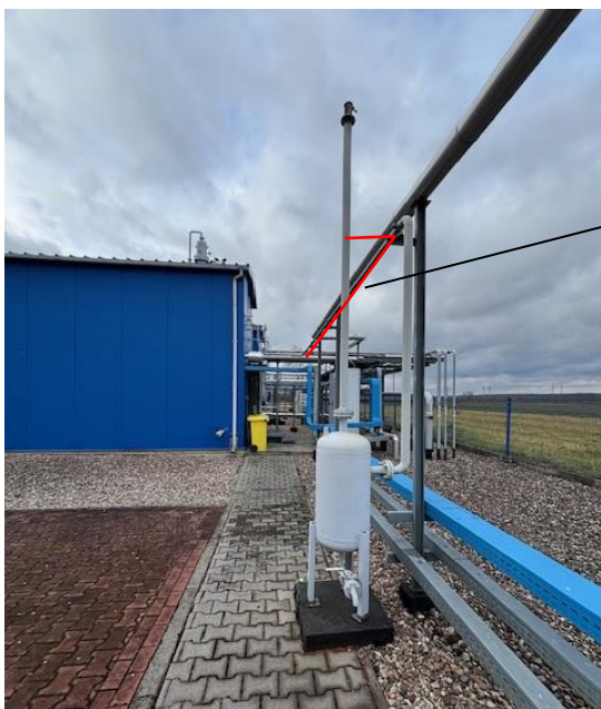
Zbiornik ociekowy dla gazu nadmiarowego z poduszek gazowych V-840
